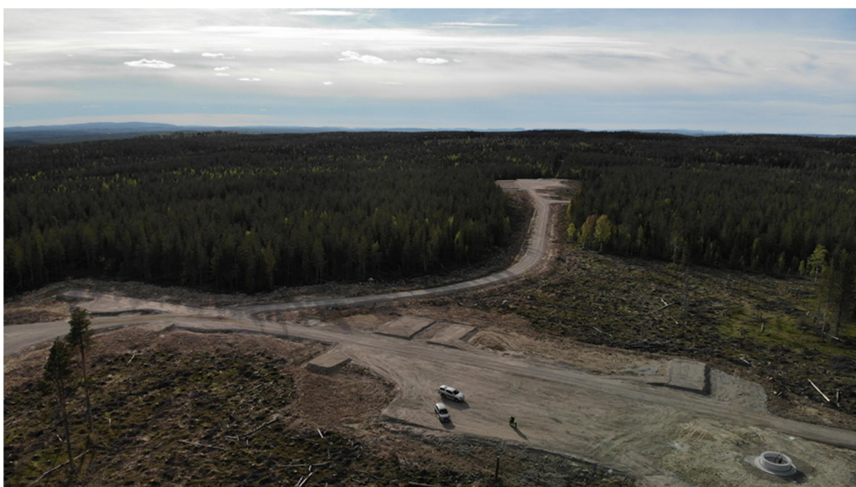
FIGUR 19. ETABLERINGSYTA MED VÄGAR FÖRE RESNING AV VINDKRAFTVERK. ETABLERINGSYTA MED VÄGAR FÖRE RESNING AV VINDKRAFTVERK. I HÖGRA HÖRNET AV BILDEN SES HUR ETT GRAVITATIONSFUNDAMENT SER UT EFTER ÅTERFYLLNAD. (FOTO: ARCTAN AB)
