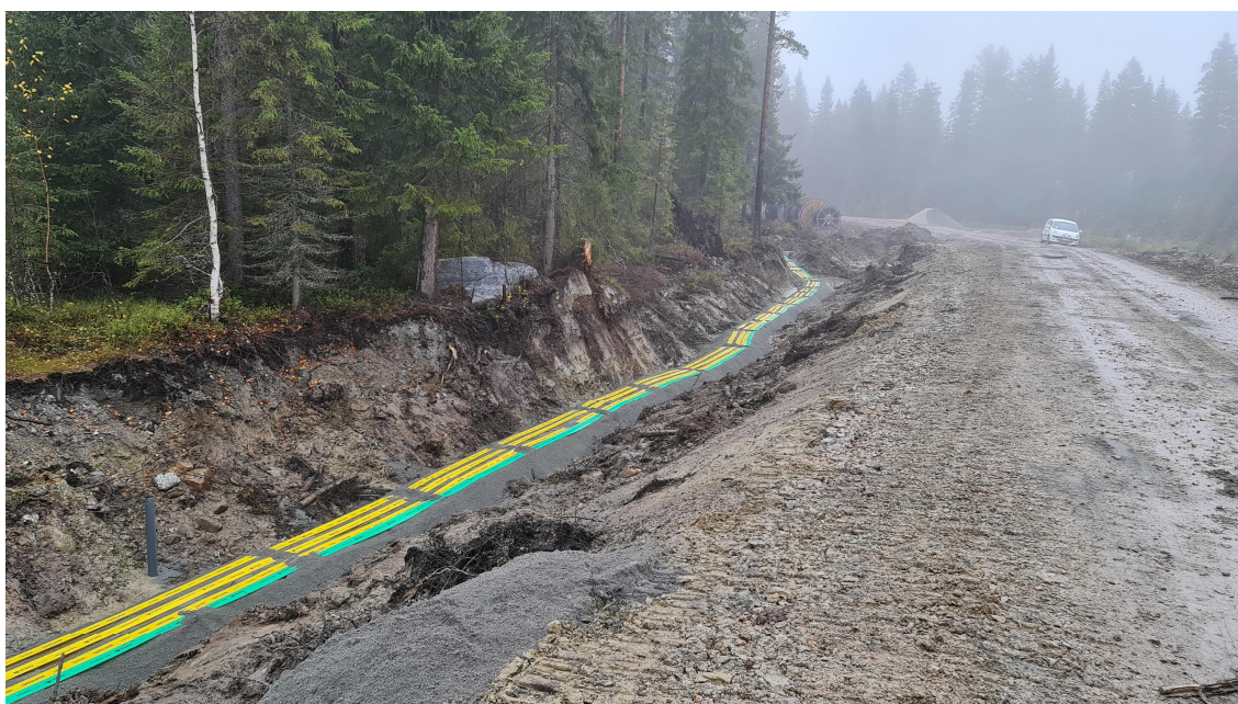
FIGUR 21. KABELGRAV MED KRAFTKABEL OCH FIBERKOMMUNIKATIONSNET INTILL VÄG. (FOTO: ARCTAN AB)
