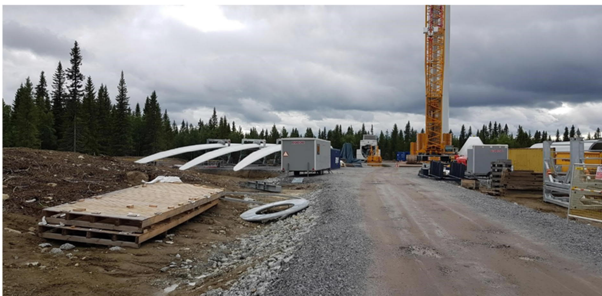
FIGUR 18. UPPSTÄLLNINGSYTA UNDER RESNING AV VINDKRAFTVERK. (FOTO: ARCTAN AB)
