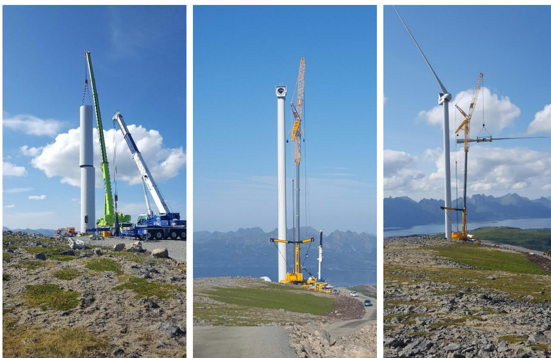
FIGUR 22. EXEMPEL PÅ INSTALLATION AV DE FÖRSTA TORNSEGMENTEN MED EN MINDRE MOBIL KRAN SAMT INSTALLATION AV MASKINHUSET OCH ROTORBLAD MED HUVUDKRANEN SOM I DETTA FALL DELVIS MONTERAS PÅ PLATS.
