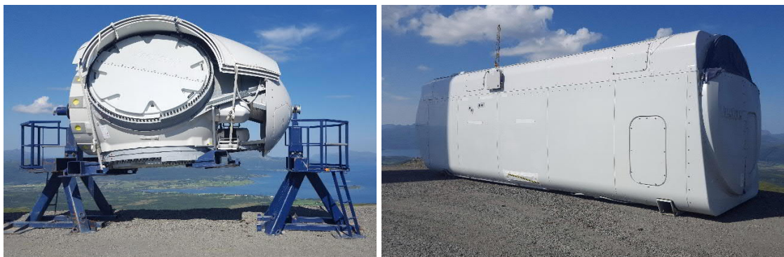
FIGUR 3. ROTORDEL I FORM AV NAVET INNAN INFÄSTNING AV ROTORBLAD (VÄNSTER) OCH MASKINHUS (HÖGER).
