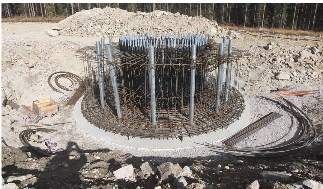
FIGUR 9. BYGGNATION AV BERGSFÖRANKRAT FUNDAMENT VID SÖKANDENS VINDKRAFTSPARK BLÅBERGSLIDEN.
