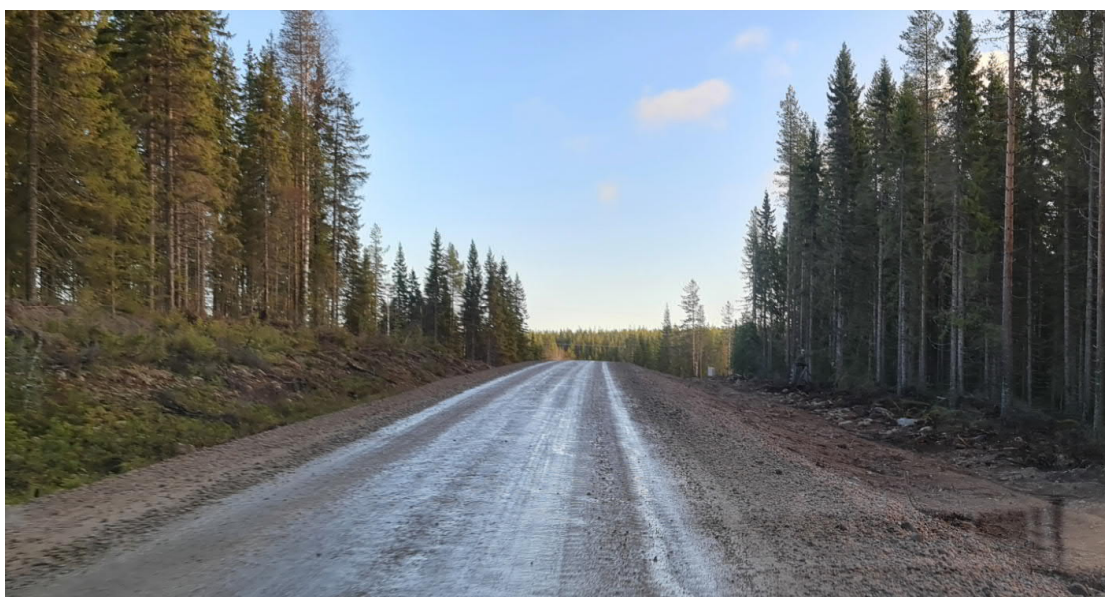
FIGUR 16. EXEMPEL PÅ BREDDAD VÄG I BEFINTLIG VÄGSTRÄCKNING, ENKELSIDIG BREDDÖKNING. (KÄLLA: ARCTAN AB)
