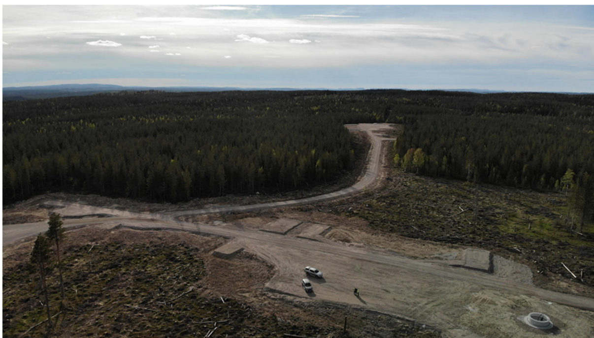
FIGUR 19. ETABLERINGSYTA MED VÄGAR FÖRE RESNING AV VINDKRAFTVERK. I HÖGRA HÖRNET AV BILDEN SES HUR ETT GRAVITATIONSFUNDAMENT SER UT EFTER ÅTERFYLLNAD. (FOTO: ARCTAN AB)
