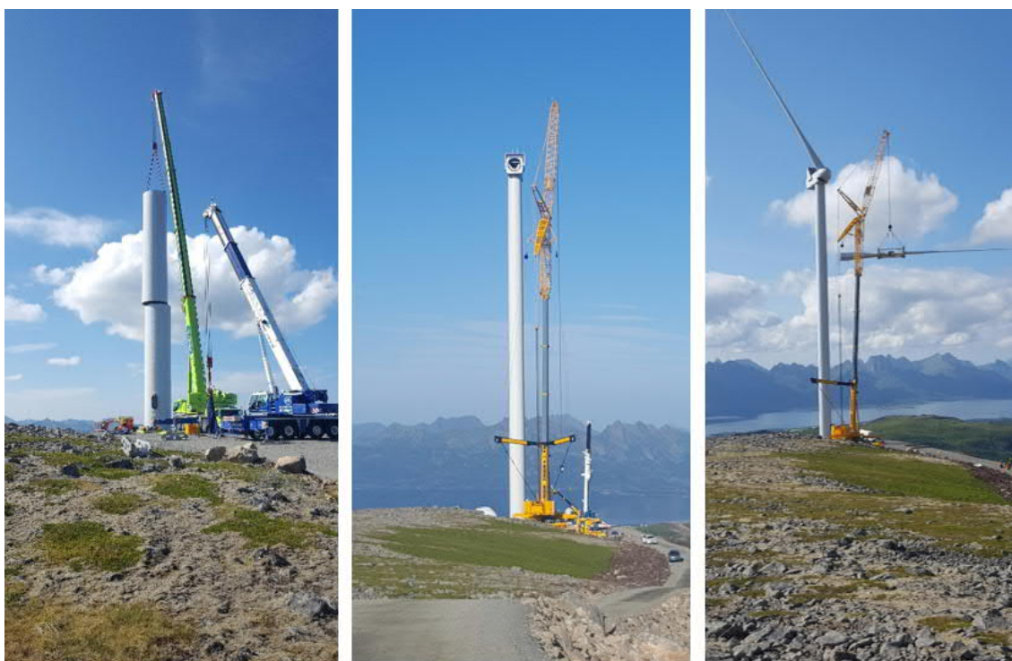
FIGUR 22. EXEMPEL PÅ INSTALLATION AV DE FÖRSTA TORNSEGMENTEN MED EN MINDRE MOBIL KRAM SAMT INSTALLATION AV MASKINHUSET OCH ROTORBLAD MED HUVUDKRANEN SOM I DETTA FALL DELVIS MONTERAS PÅ PLATS.
