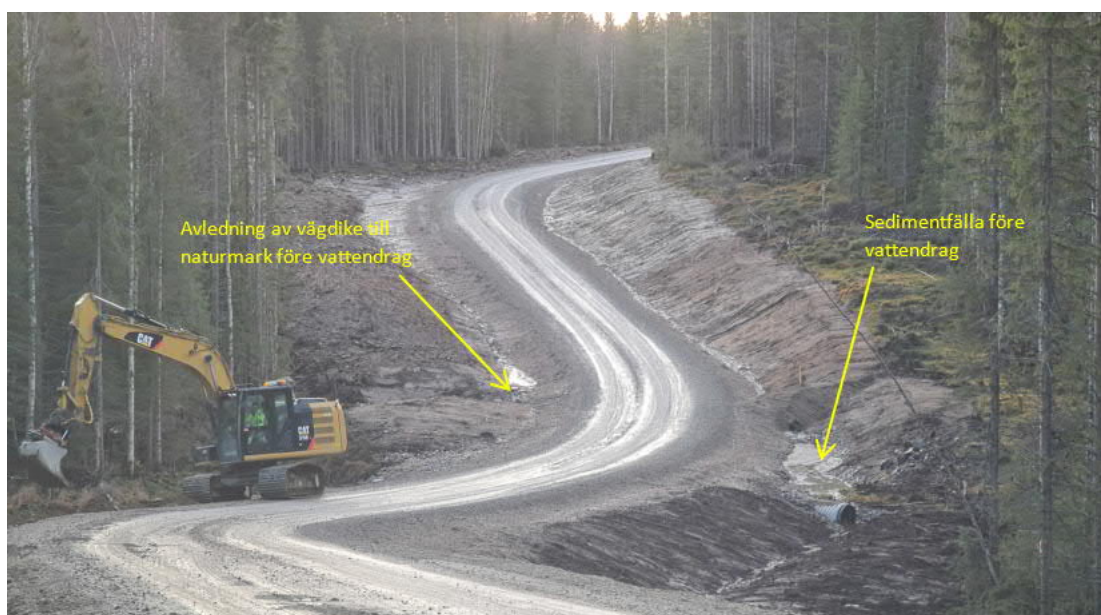
FIGUR 15. EXEMPEL PÅ NYANLAGD VÄG OCH PASSAGE AV VATTENDRAG. (KÄLLA: ARCTAN AB)
