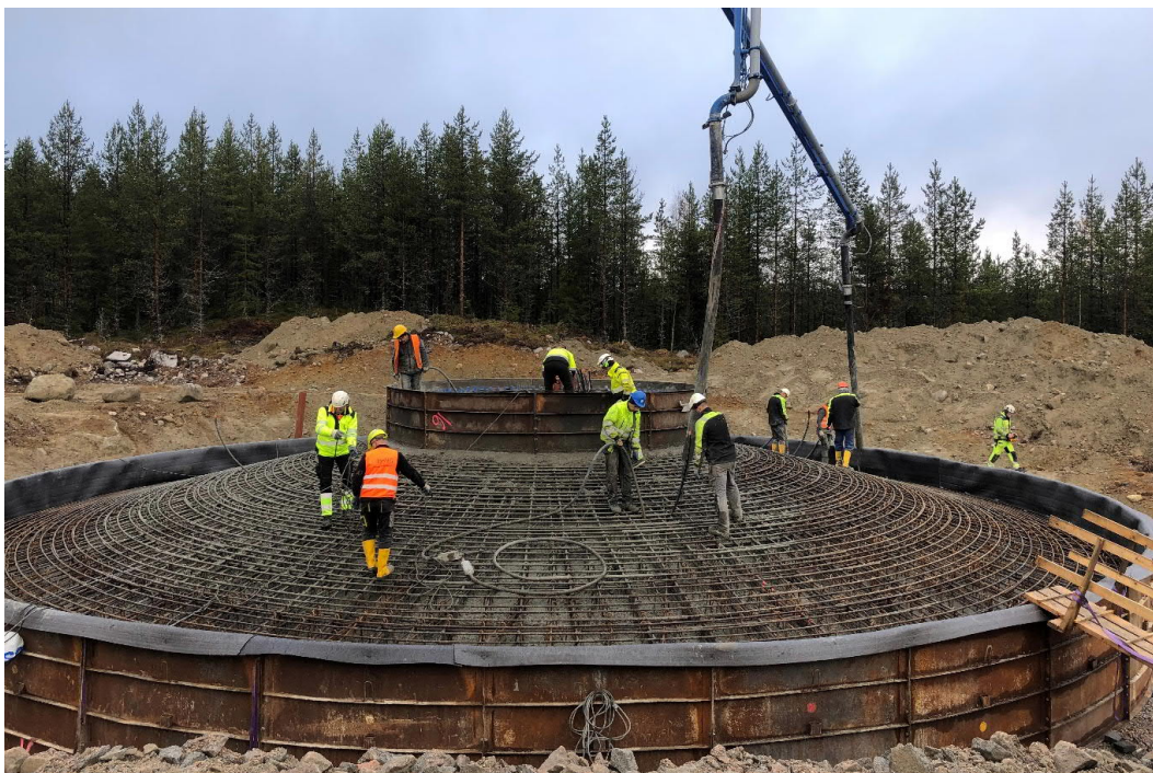
FIGUR 8. BYGGNATION AV GRAVITATIONSFUNDAMENT VID SÖKANDENS VINDKRAFTSPARK BLÅBERGSLIDEN. HÄR SYNS DEL AV ARMERINGEN UNDER PÅGÅENDE BETONGGJUTNING.
