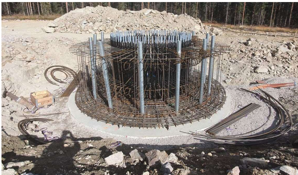
FIGUR 4-5: BYGGNATION AV BERGSFÖRANKRAT FUNDAMENT VID VINDKRAFTSPARK BLÅBERGLIDEN.
